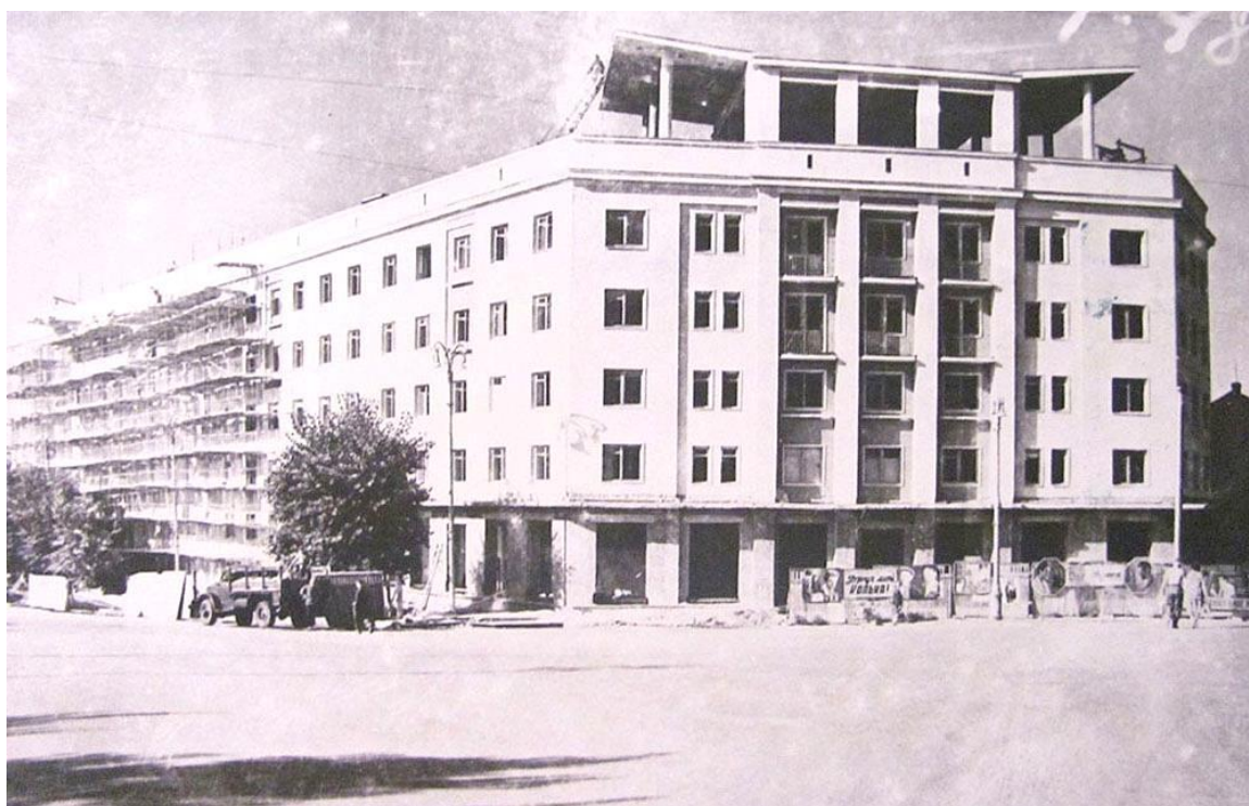
Дом с «крыльями Теплицкого» в процессе реконструкции. Строительные леса над местом бывшего рва курского кремля Сайт http://old.rursk.ru .
