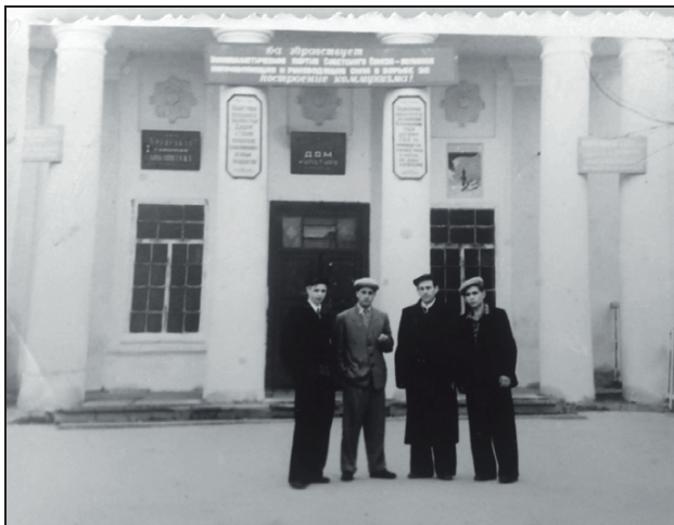
Рис. 8. Дом культуры (бывшая Покровская церковь) в с. Крупец. Северный фасад. 1960-е годы. (Архив Р. А. Петуниной).
