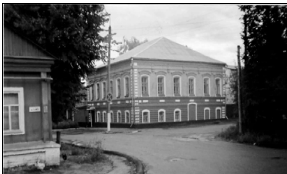
Дом купца Разинкина (ныне здание Обоянского районного суда)
