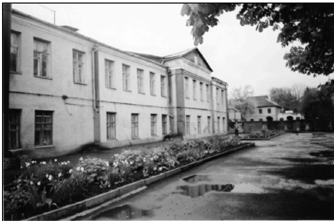
Главный учебный корпус лицея
